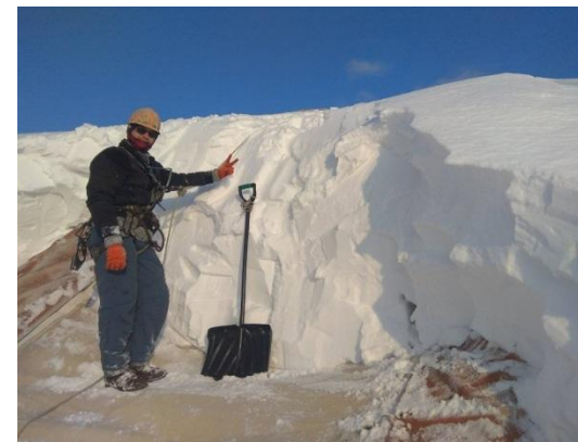
Чистка тентовой кровли от снега и наледи более 10 000 м 2
