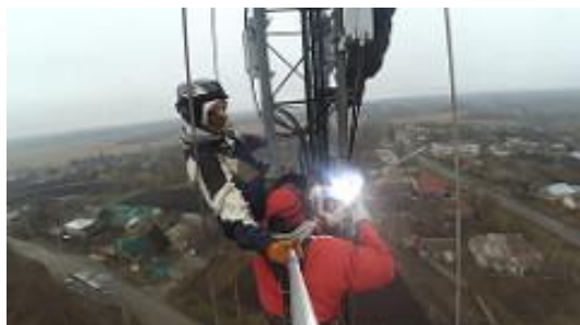
Монтаж антенно-фидерного оборудования (3 баз.станции)
