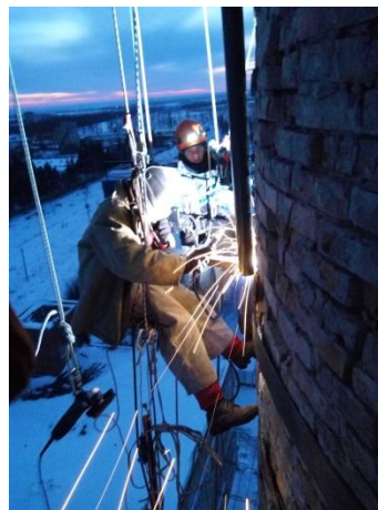
Сварочные работы на промышленном дымоходе при монтаже антенно-фидерного оборудования(2 баз.станции)
